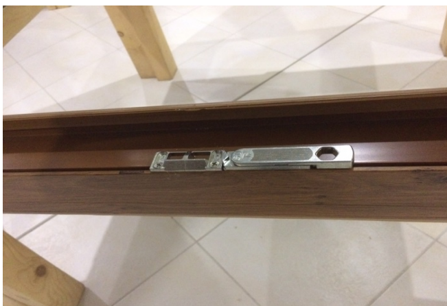
Fixation de la platine
