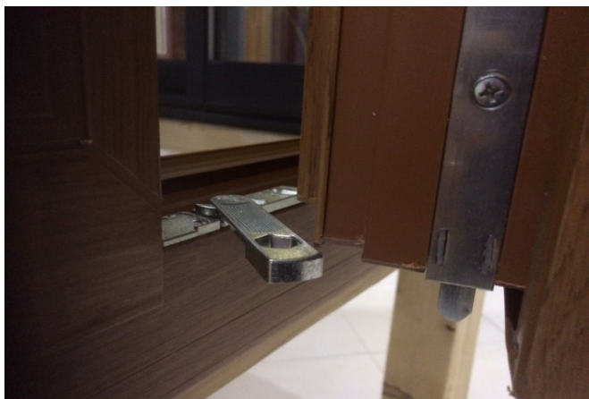
Vérification de l'alignement
