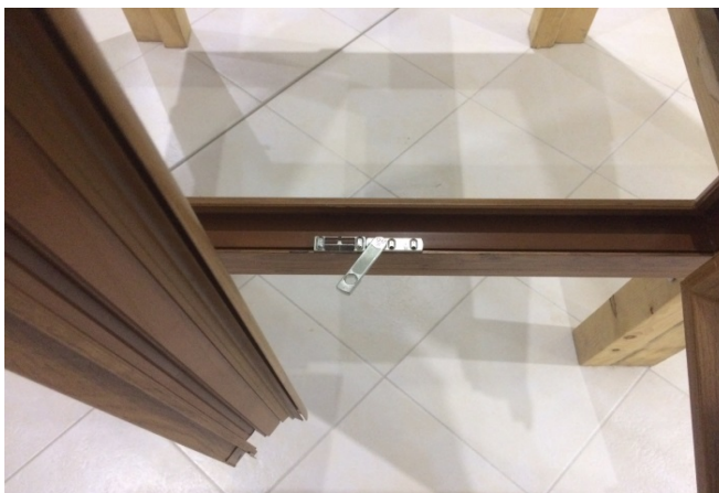
Pose de l'entrebailleur à côté de la gâche
